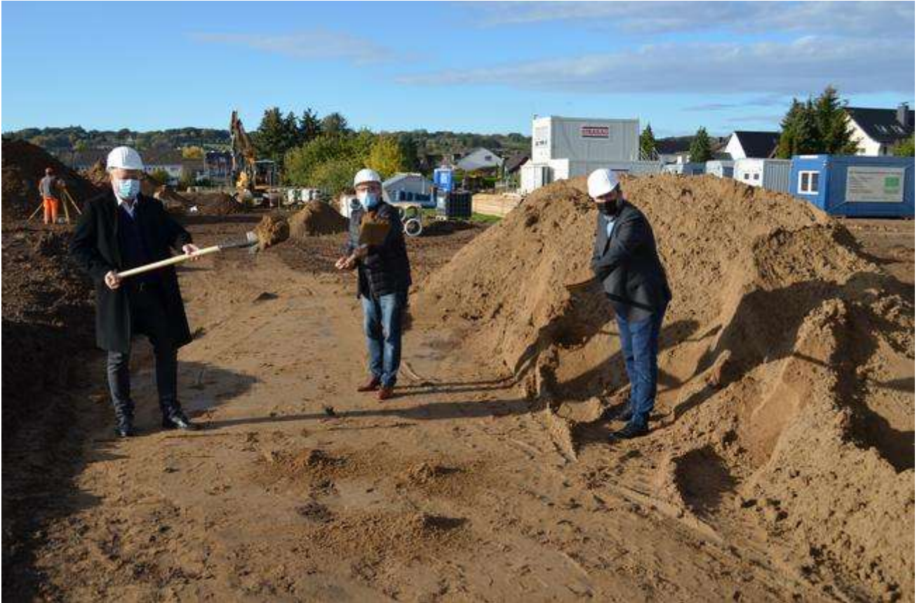
Bürgermeister Wolfgang Henseler übernimmt gemeinsam mit Montana-Prokurist Heiko Bartelt (links) und Holger Weber (Strabag) den ersten Spatenstich
