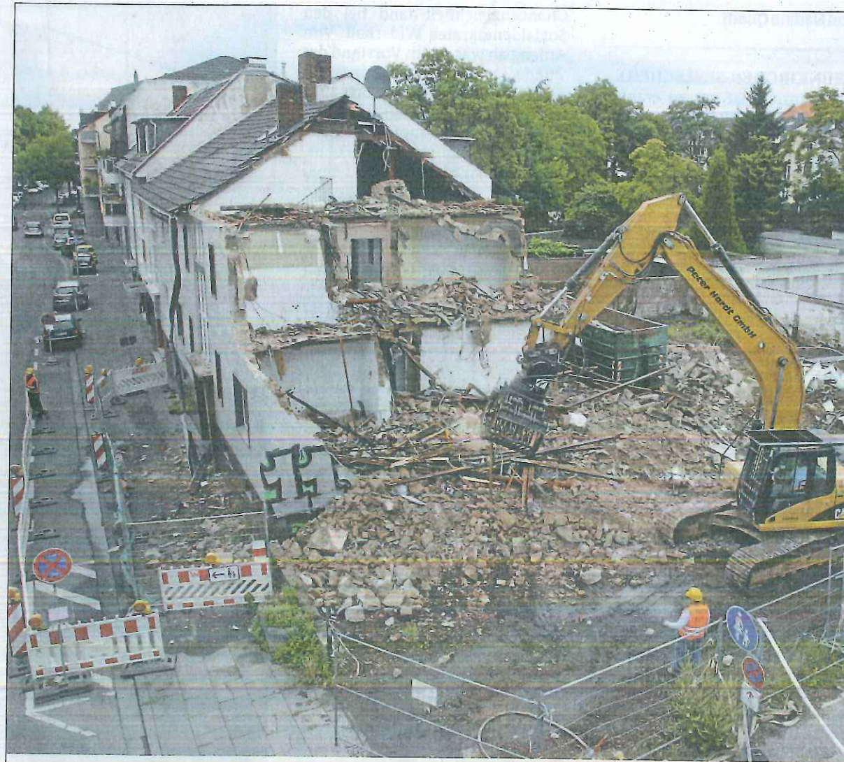
Bereits nach wenigen Stunden war das erste Haus fast komplett abgerissen.
